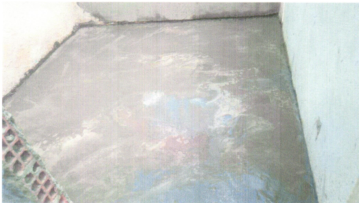
Foto 07- PISO EM CONCRETO 20MPA PREPARO MECÂNICO, ESPESSURA 7CM. AF_09/2020
