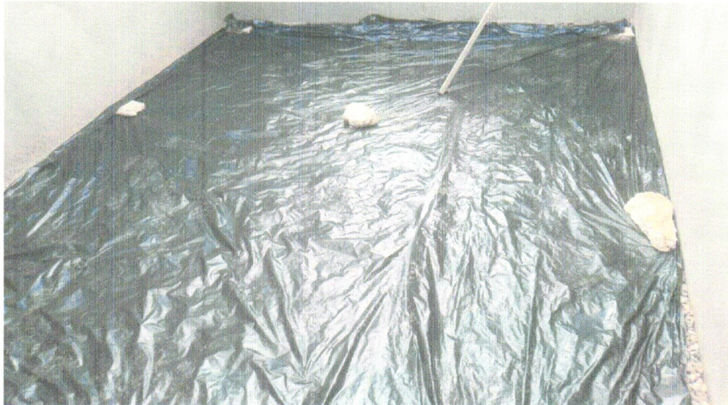
FOTO 13 - APLICAÇÃO DE LONA PLÁSTICA PARA EXECUÇÃO DE PAVIMENTOS DE CONCRETO. AF04/2022
