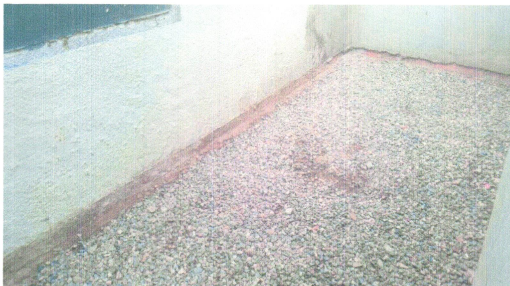
FOTO 11 - Lastro de brita graduada apiloada e=10cm
