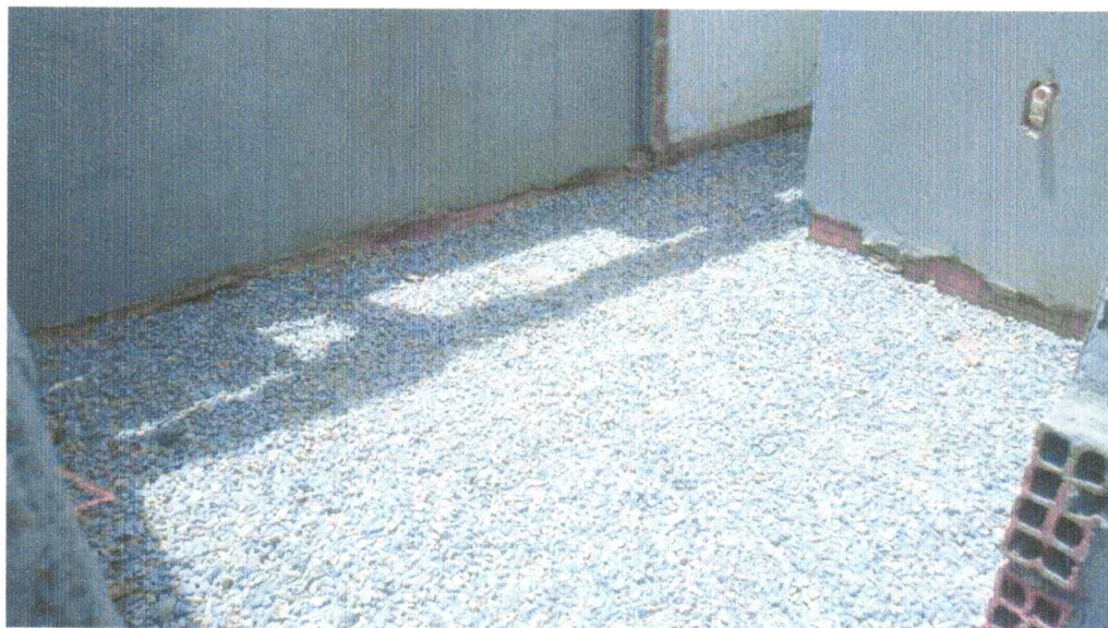
FOTO 06 – Lastro de brita graduada apiloada e=10cm
