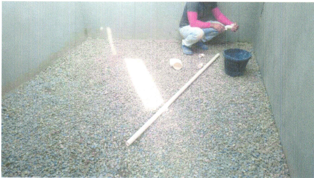
FOTO 05 – Lastro de brita graduada apiloada e=10cm
