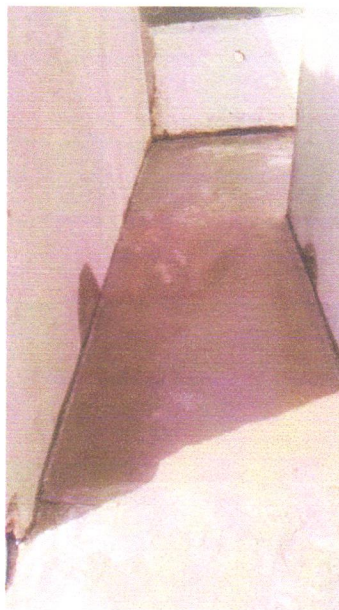
FOTO 01 - PISO EM CONCRETO 20MPA PREPARO MECÂNICO, ESPESSURA 7CM. AF_09/2020
